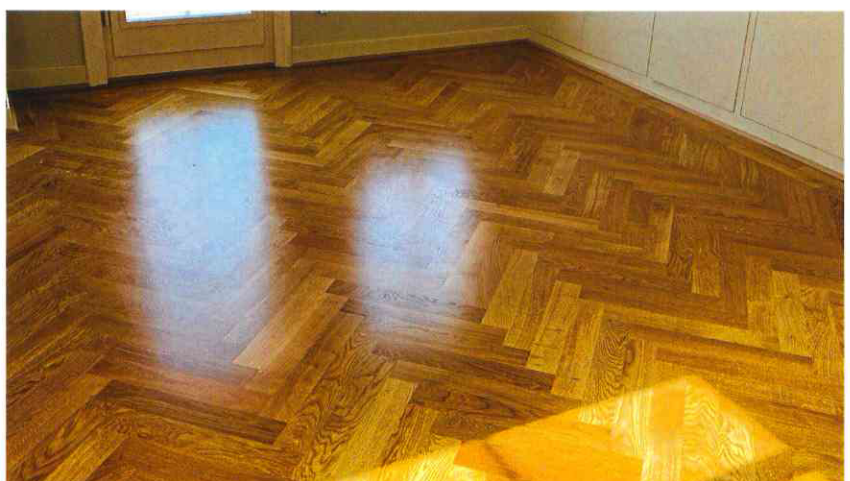
Insgesamt 100 m 2 Eicheparkett haben die Profis von Link Bodenkonzepte in einer denkmalgeschützten Privatvilla neu verlegt.
