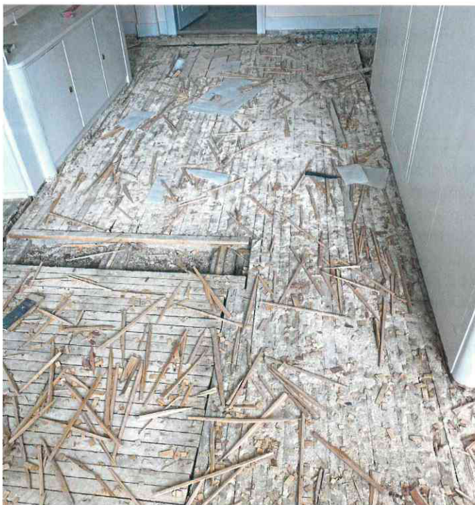
Vorher – nachher: Die Herausforderungen bei diesem Bauvorhaben lagen insbesondere bei der aufwendigen Untergrundvorbereitung.
